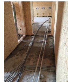
Rohrinstallation WC-Trakt
