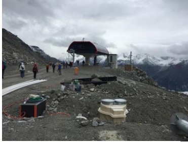
Neue Bergstation Plattja
